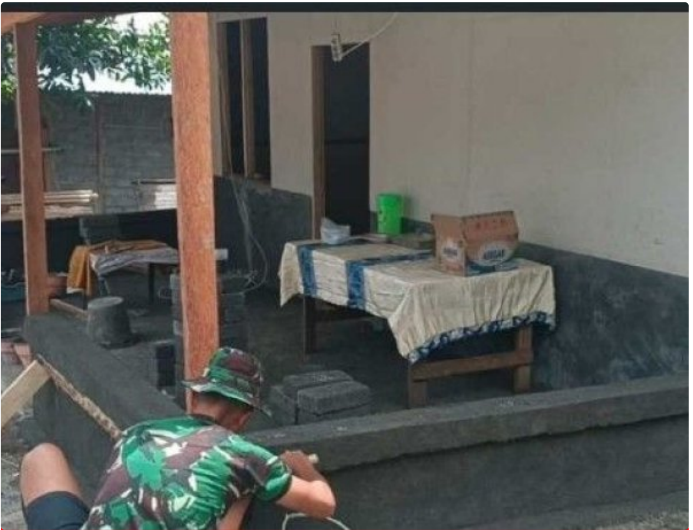
Satgas TMMD Kodim 1310 Bitung dalam Pekerjaan RTLH
